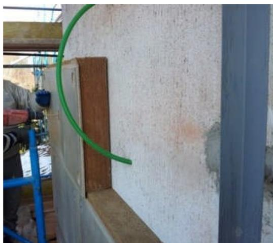
**Fig. 2 - Applicazione di cappotto esterno in fibra di legno**
